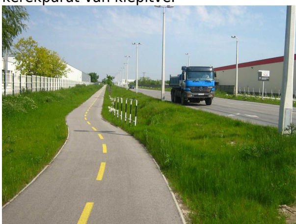
Keleti lekerülő út – zöld sávval elválasztott kétirányú, jó állapotban levő kerékpárút
