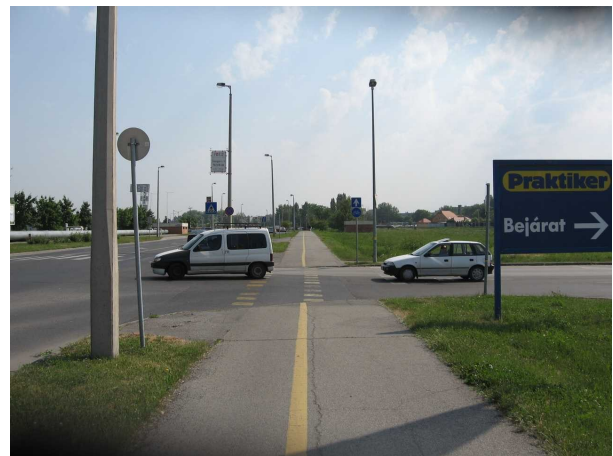
Szauter Ferenc út – meglévő közös gyalogos- és kerékpárút elválasztással és meglévő kétoldali egyirányú kerékpárút sárga színű felfestéssel elválasztva
